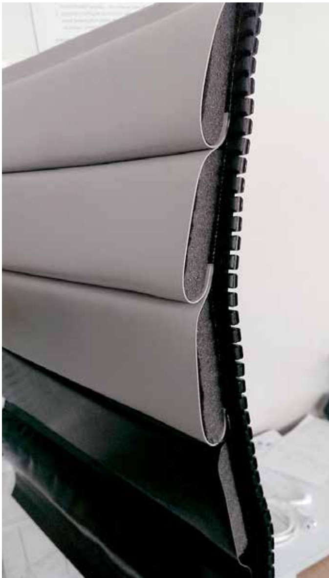
Detalle aislamiento interno, lona con cremallera de polímero
