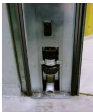
Detalle guías autorreparables y sistema de aire calefactado
